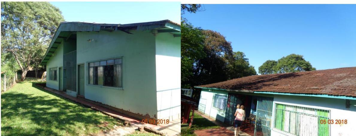
1.1.4.3 Novo telhamento: Após a remoção, deverá ser instalado na cobertura telhamento com telhas em aluzinco termoacústica modelo TP 40 -- aluzinco 0,5 mm, (com EPS 30mm e isofilme branco - modelo telha/telha), ou similar. A inclinação poderá seguir conforme o existente.
